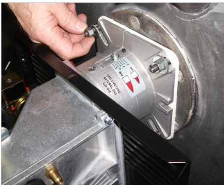
7) Зафиксировать горелки на котел;
