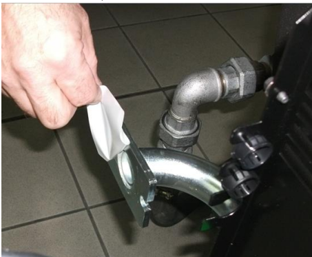
7) Снять заглушку из Труба ГАЗОВОЙ рампы;
