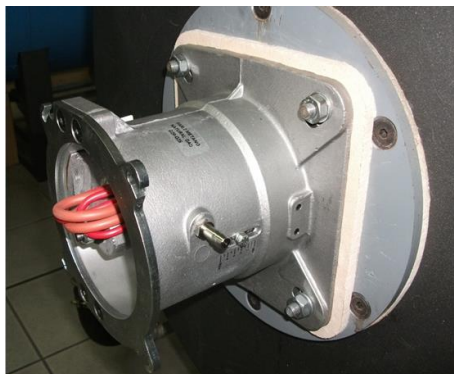
2) Смонтировать Смесительную Группу на котле;
