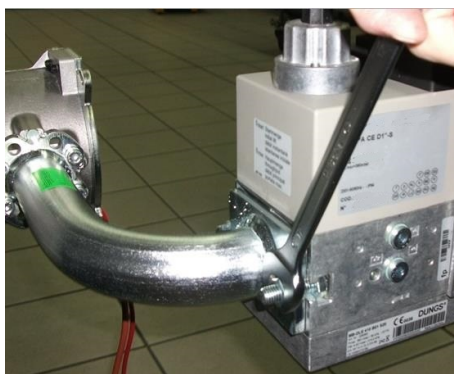
8) установить электроклапан и Прикрепить из фланец;
