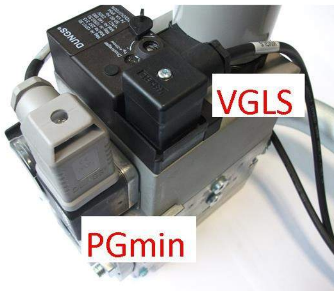
Fig. 9 Электрические соединения к газовой магистрали
